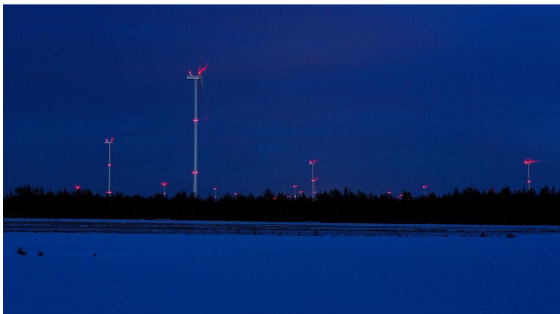
Kuva 38. Kiinteät punaiset lentoestevalot pimeällä. (Kuva: Ville Suorsa/FCG)
